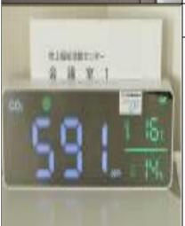
施設の玄関に検温を容易に行うことができるサーモカメラを設置し、また、各部屋に 二酸化炭素濃度が大きく表示される二酸化 炭素濃度測定器を設置しました。
